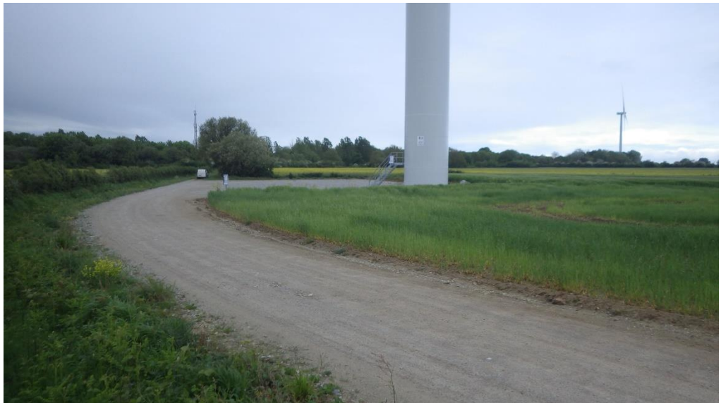
Figure 3 Eolienne 3 le 3 mai 2018
